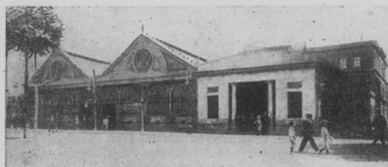
Fachada de la segunda estación de Barcelona-termino, en el Paseo de la Aduana
